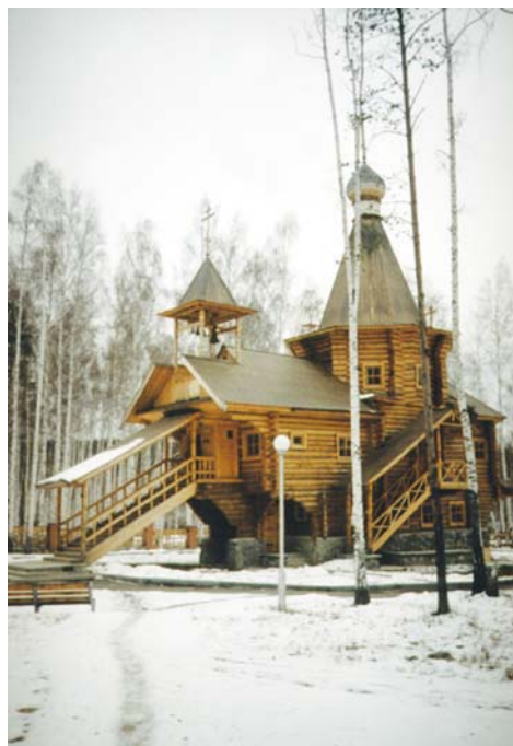
Ил. 1. Общий вид церкви во имя прп. С. Саровского, г. Новоуральск
